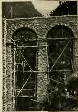
Abb. 128. Trisana-Viaduct. [Pfeilerbau.] [Nach einer photographischen Aufnahme von J. Czichna, Innsbruck.]
